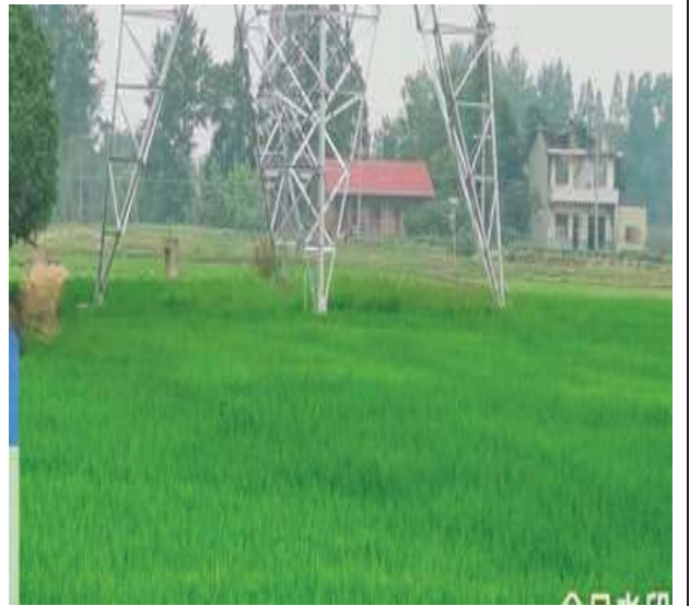
牵张场植被恢复情况（#80 塔基附近）
