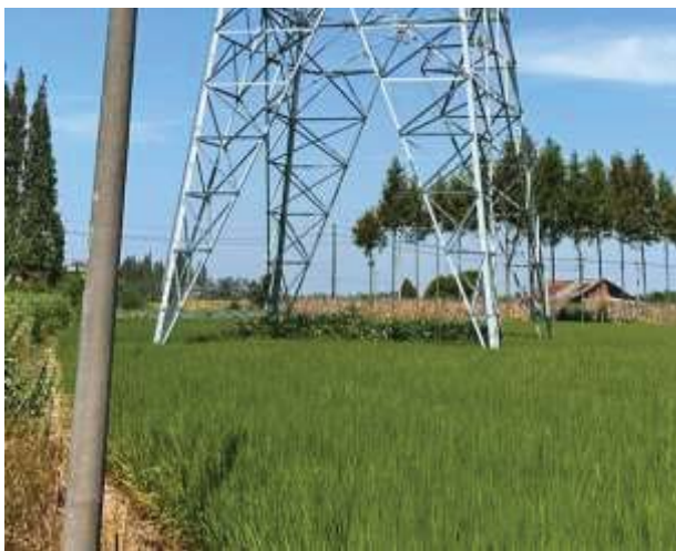
基础施工后对农田复耕（#4 塔基下方）
