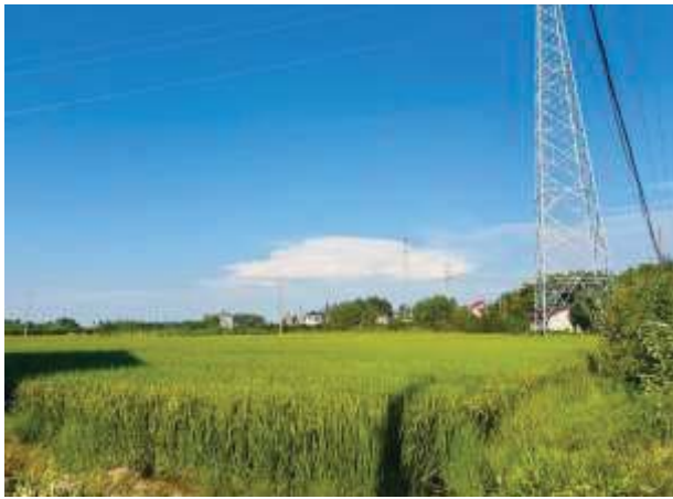
牵张场植被恢复情况（#85 塔基附近）
