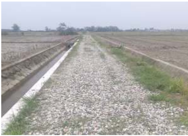
临时道路恢复情况（#51 塔基附近）
