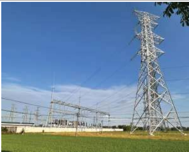
变电站扩建间隔侧现状
