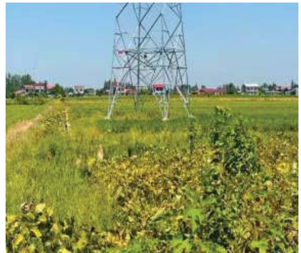
牵张场植被恢复情况（#47 塔基附近）
