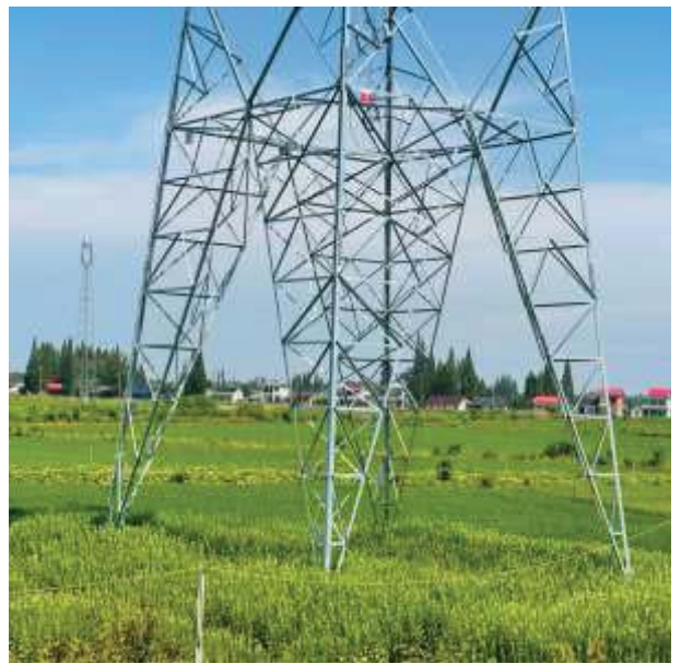
#44 塔基恢复现状
