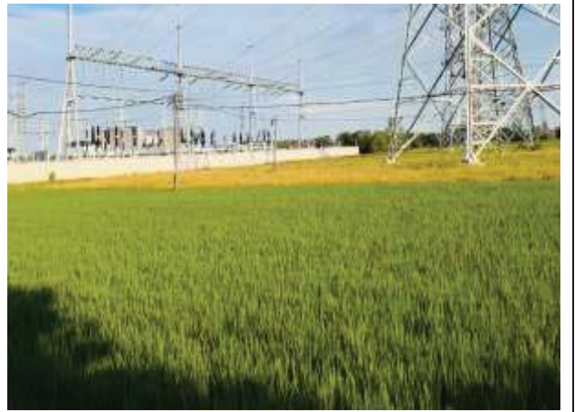
牵张场植被恢复情况（#92 塔基附近）
