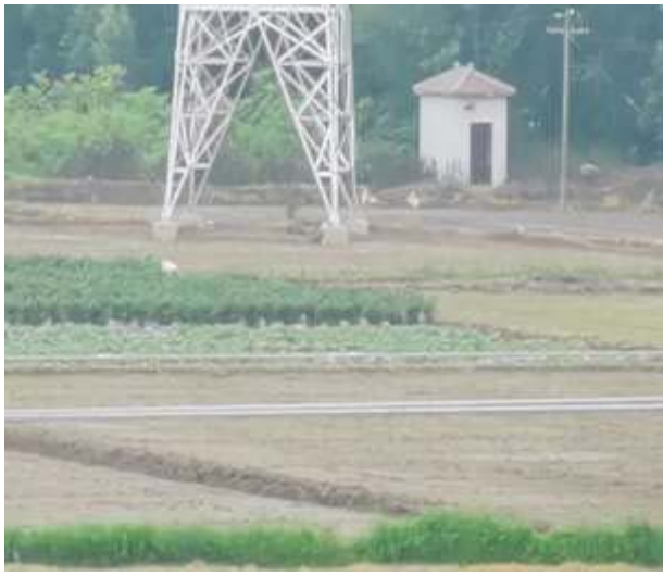
牵张场植被恢复情况（#58 塔基附近）
