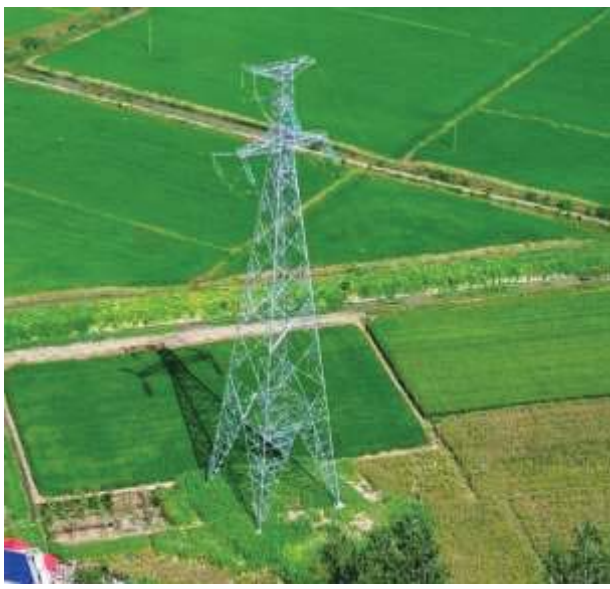
#9 塔基恢复现状
