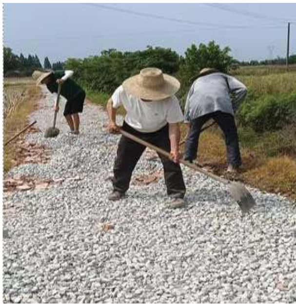
进场道路铺设碎石
