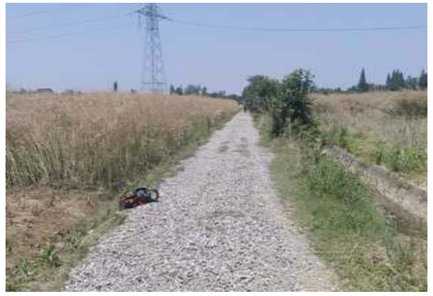
临时道路恢复情况（#85 塔基附近）
