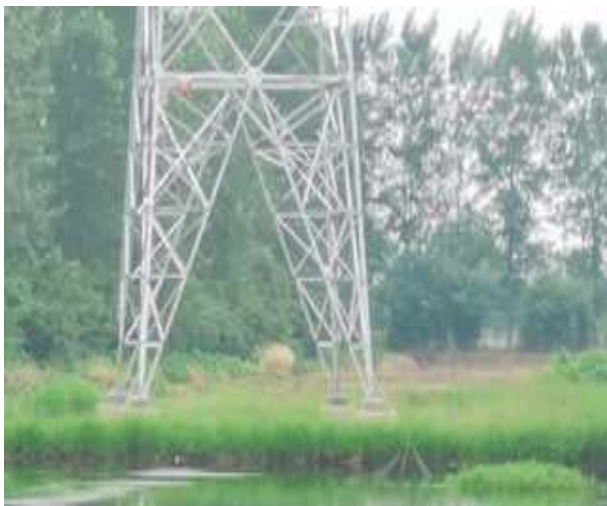
牵张场植被恢复情况（#37 塔基附近）
